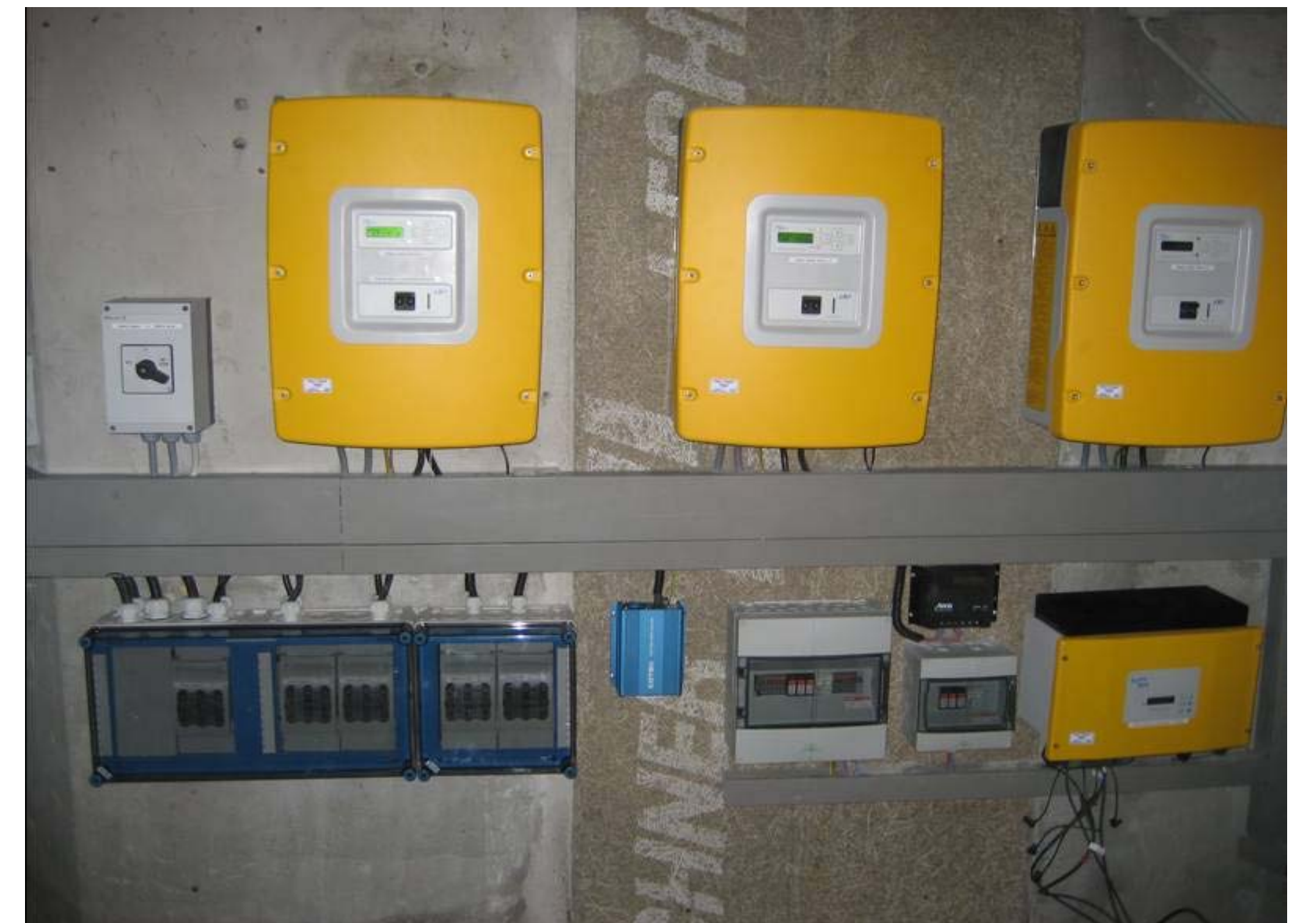
Wechselrichter
