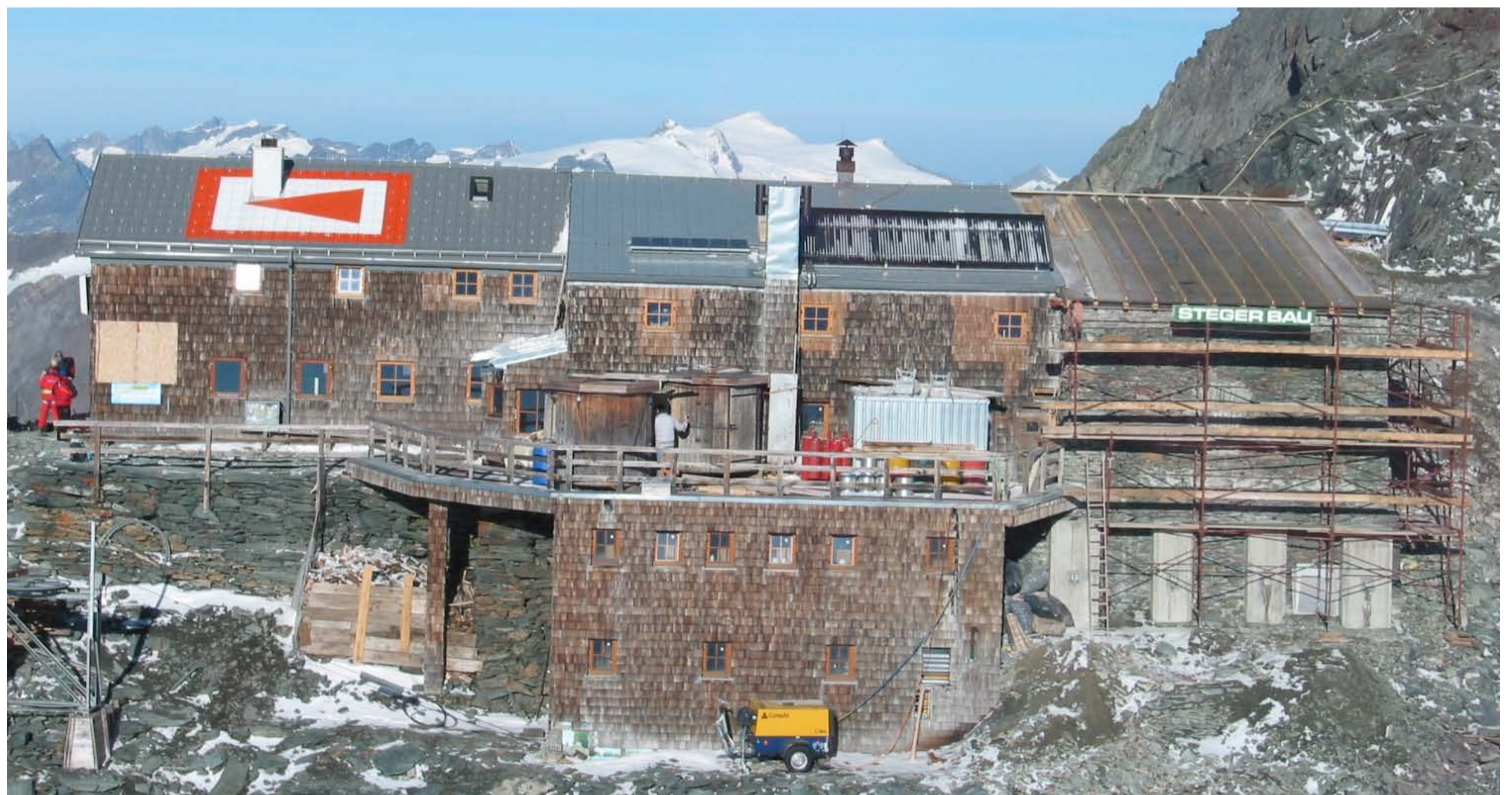
Erzherzog-Johann-Hütte, rechts der sanierte Steinbau mit Felssicherungen
