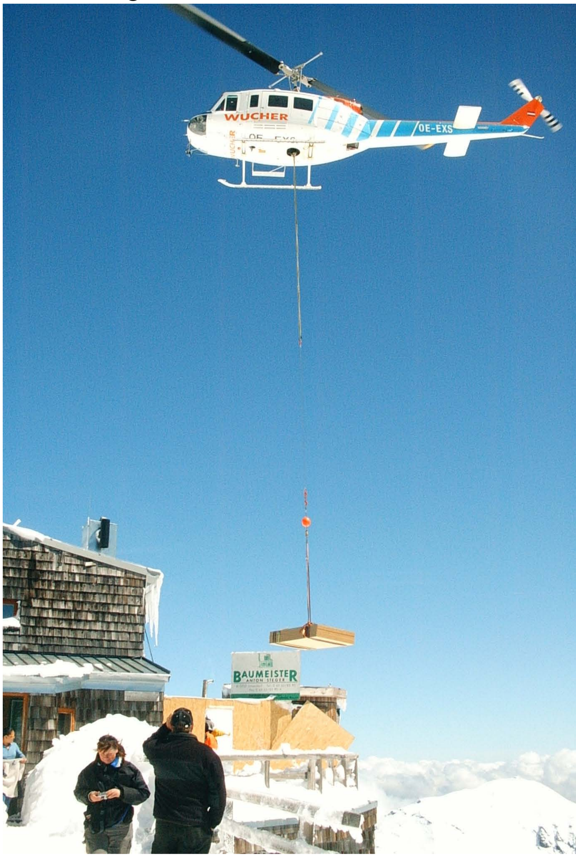
Hochbau unter extremen Bedingungen
