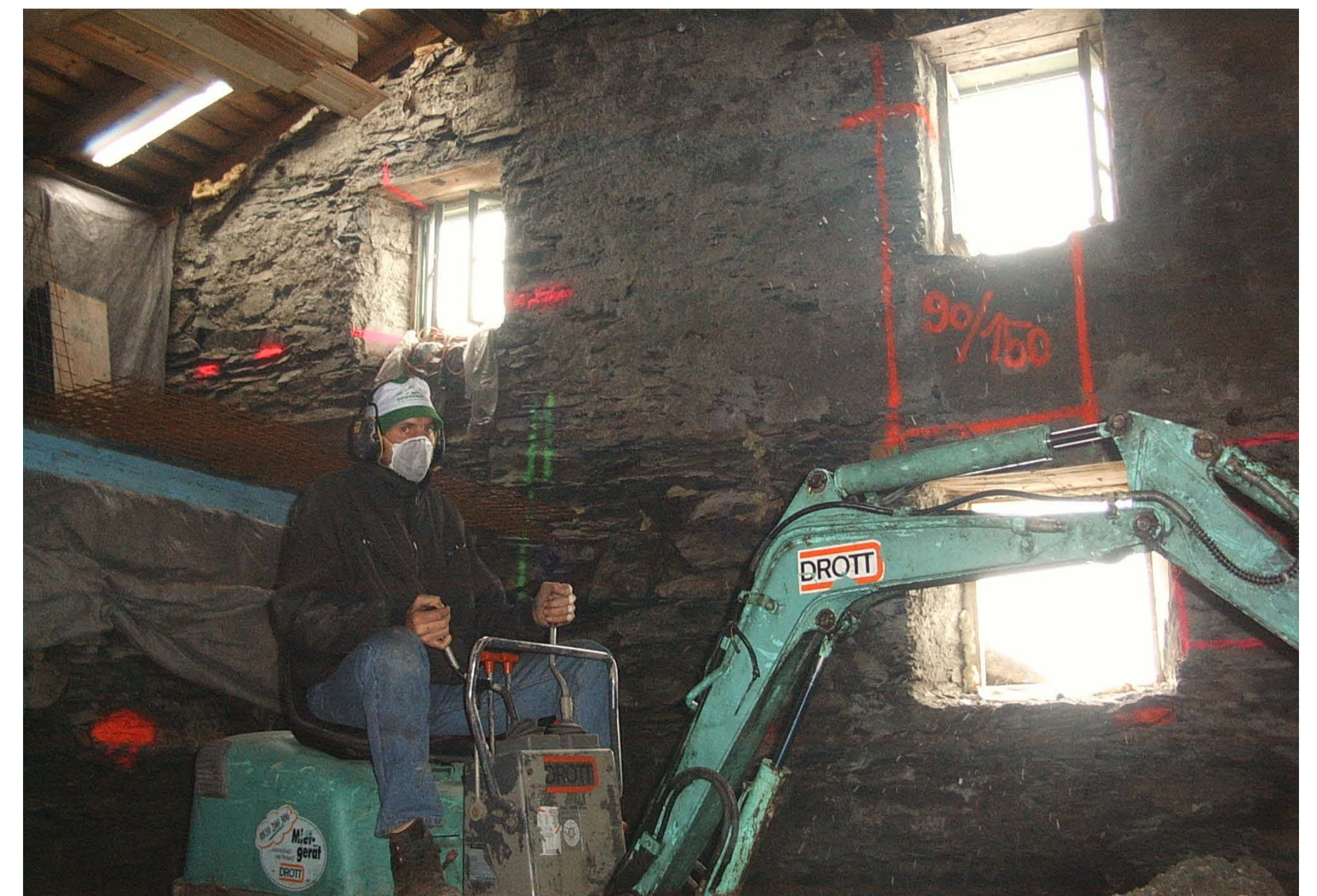
Innenausbau im Steinbau
