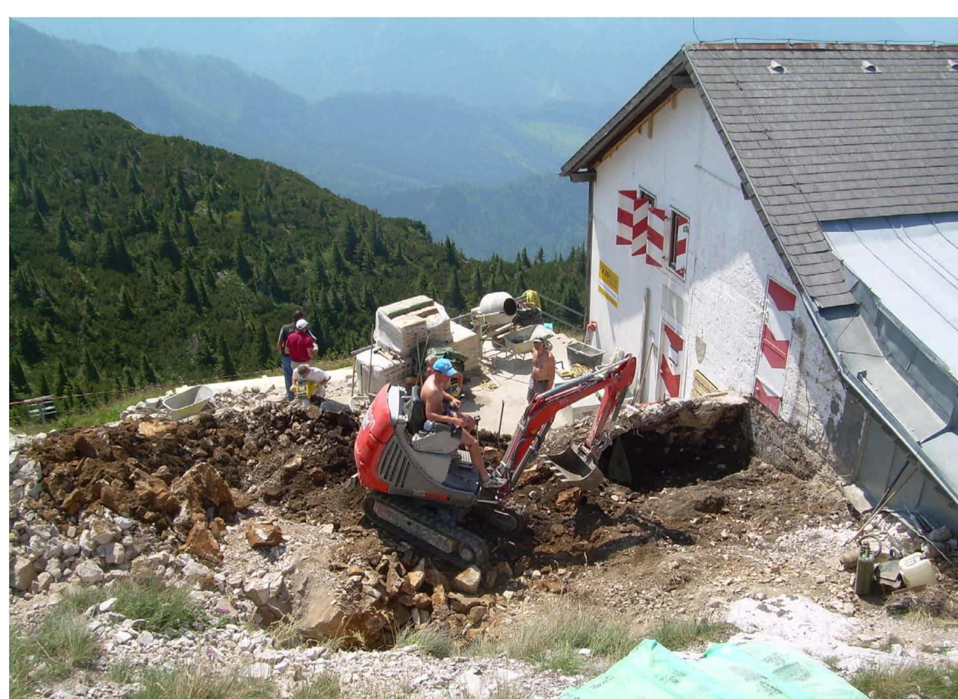
Bauarbeiten im Sommer 2007
